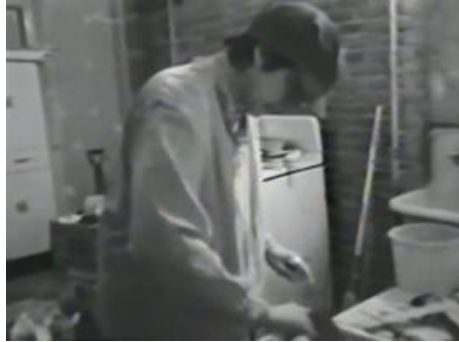
Figura 1 – Carol trabalhando na reforma do apartamento
