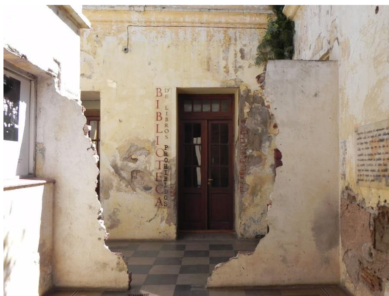
Fotografia 1: Muro derrubado com acesso a Biblioteca de livros proibidos. Foto: Marina Macambyra.
