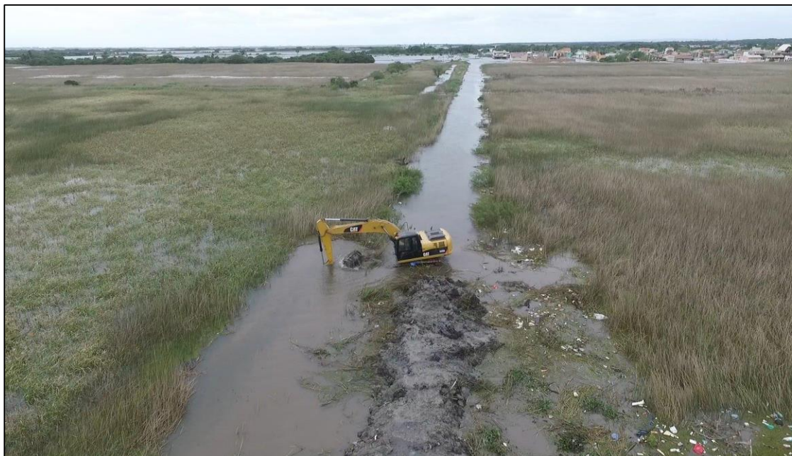
Figura 2. Construção do dique
