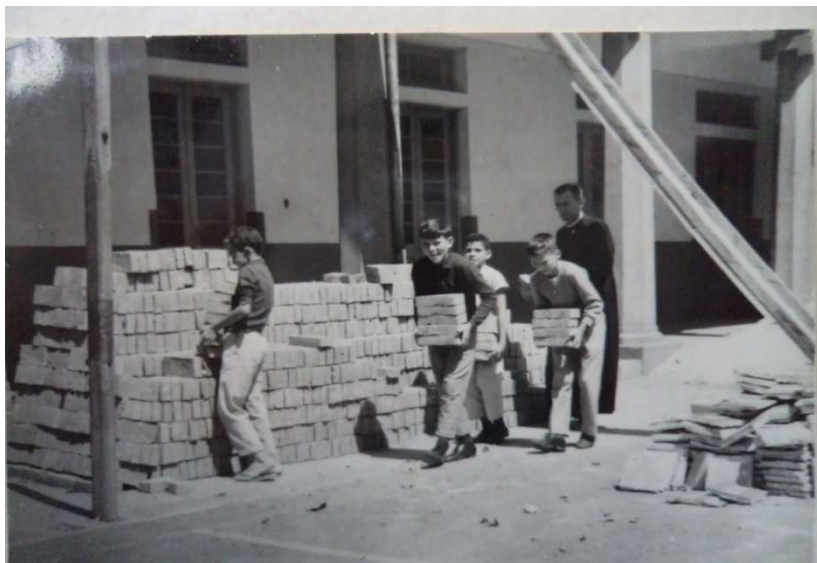
Figura 2: disciplina de construção de obras. Final da década de 1930.
