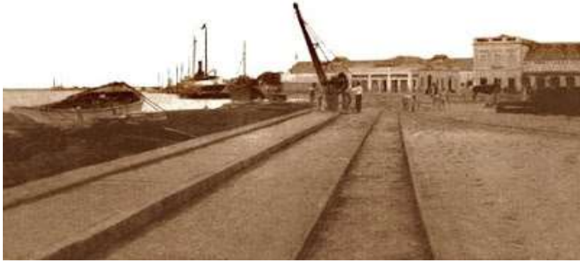
1912- Início das obras de um cais portuário público. Arquivo Morto SPH-Pelotas
