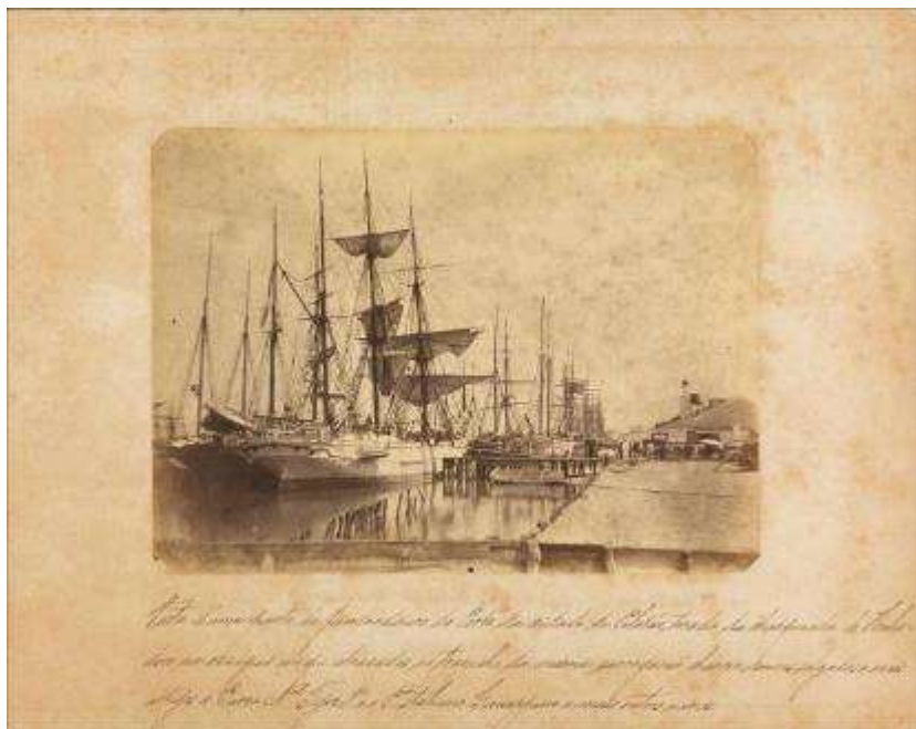
Construção dos trapiches centrais as margens do Canal São Gonçalo Foto de 18??- Arquivo da Biblioteca Nacional
