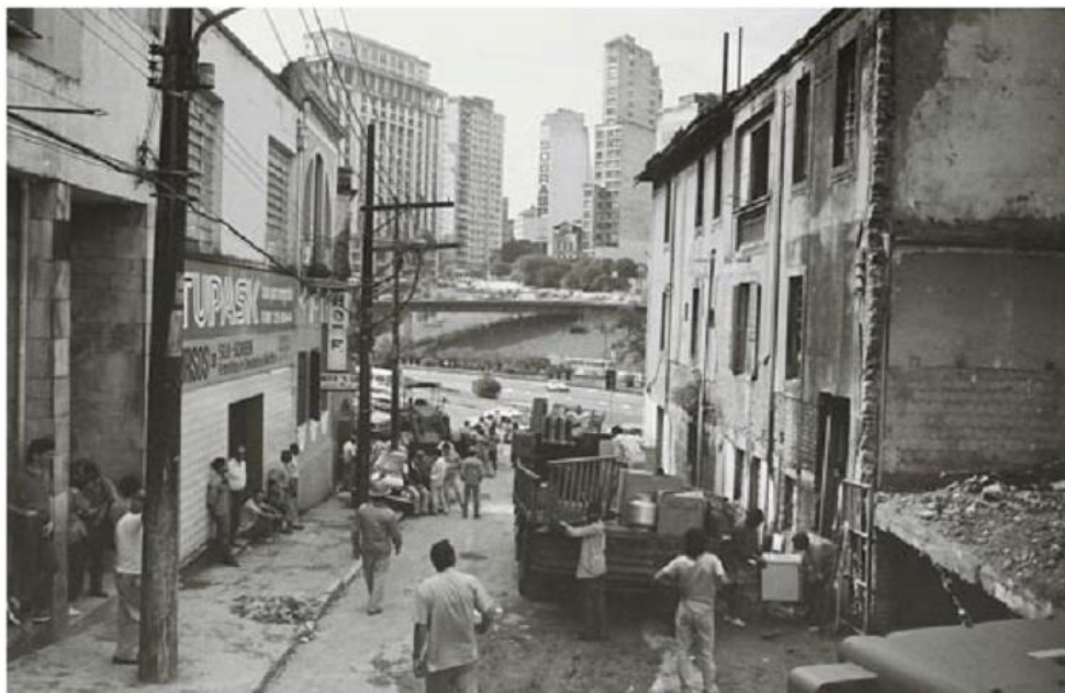
Figura 3 - Desocupação e demolição dos imóveis junto aos arcos
