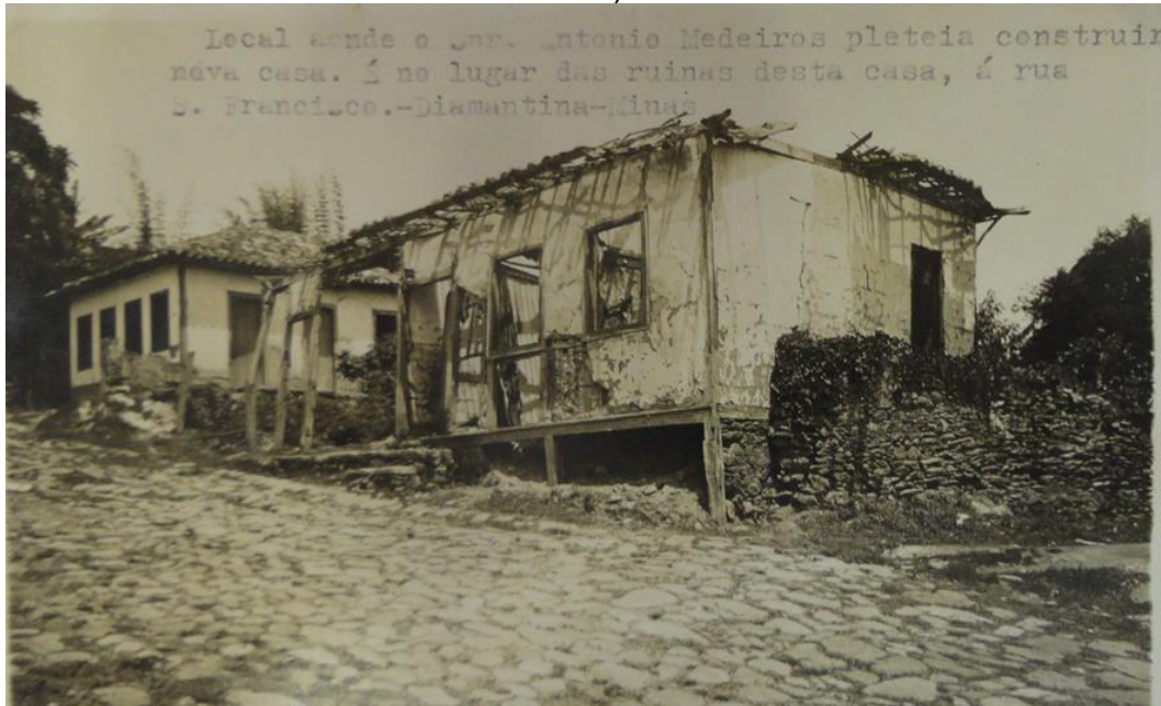
Figura 1: Propriedade de Antônio Medeiros. Solicitação de demolição de ruína (17-12-1946).
