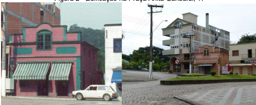
Figura 2 - Edificação na Praça Anita Garibaldi, 17
