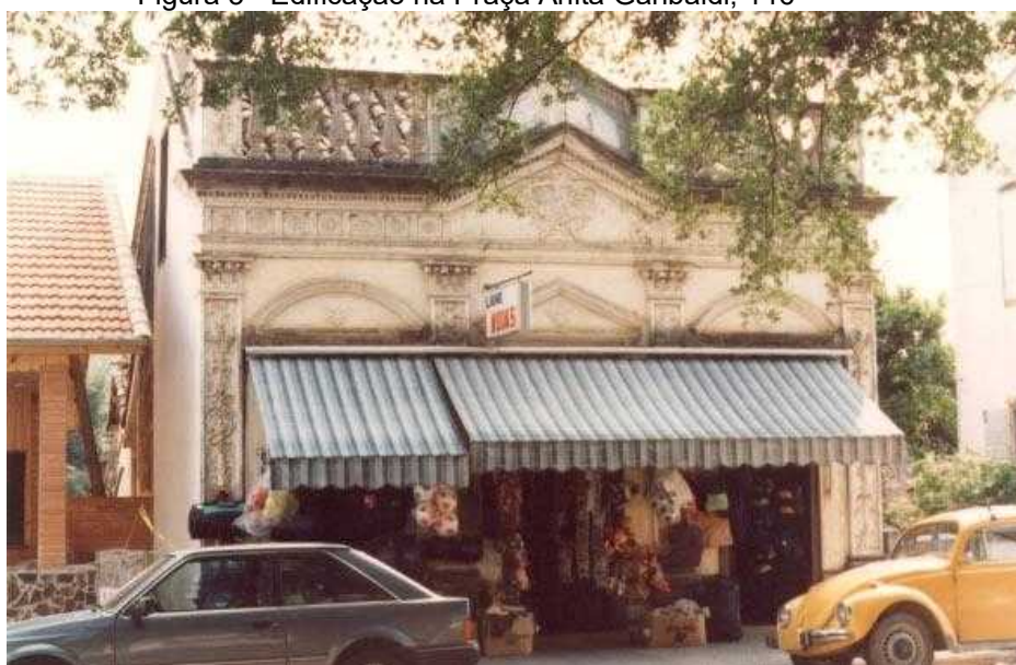
Figura 3 - Edificação na Praça Anita Garibaldi, 146
