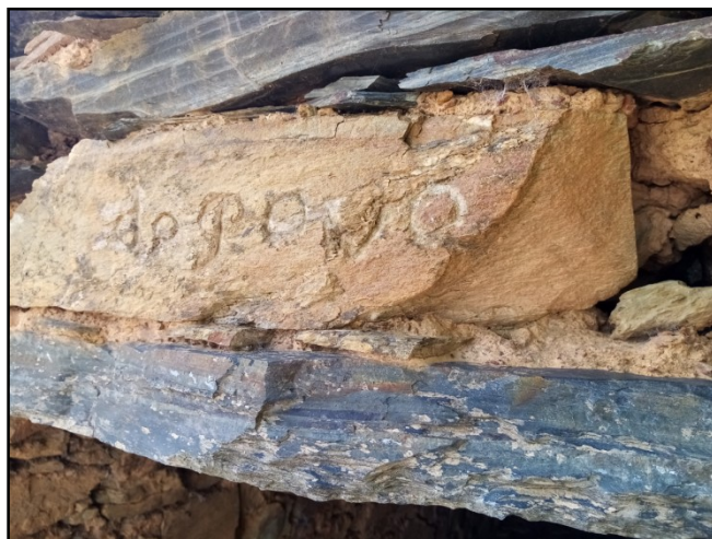
Figura 1: Muro de Xisto. Edifício Casa do Esquife, Mó. A inscrição “Do Povo” (“Do povo”) data de 1936 (data indicativa) e lembra a prática de atividades sociais comunitárias e espaços comuns. Autor: Ema Pires (2020).
