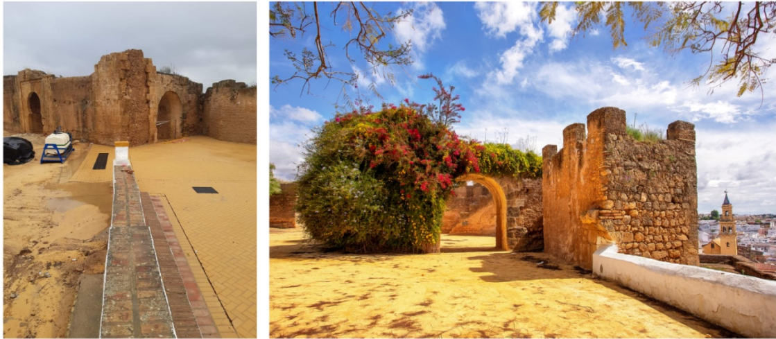
Figura 4. Estado actual (izda.) y estado anterior (dcha.) a la intervención en el entorno de la Torre Mocha, en el complejo fortificado de Alcalá de Guadaíra, percibiéndose actuaciones paramentales y en la sustitución de un pavimento de terrizo de albero por otro de adoquines. Fotografías: «El Moro del Castillo» (izda.) y Roberto Rogelio Andrade (dcha.).
