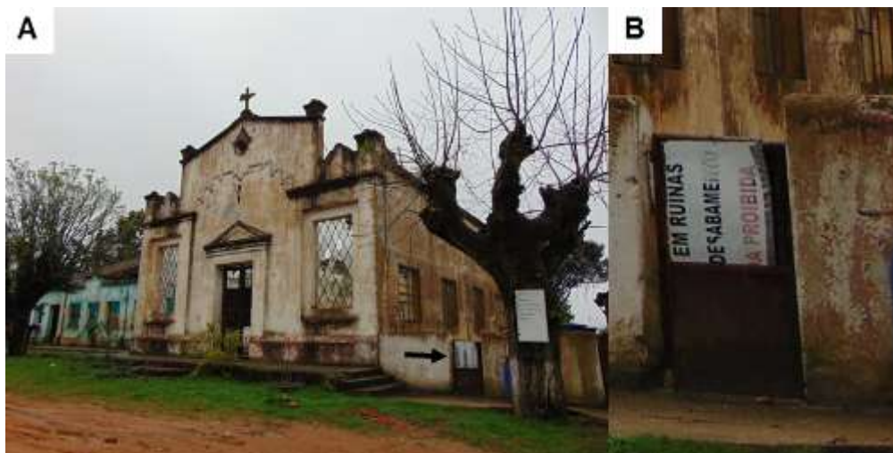
Figura 6: Em A, ruínas da Igreja associada à Charquada São Domingos, Bagé/RS. À esquerda, a EEEF Dr. Mário Olivé Suñe, e na seta, placa danificada avisando sobre risco de desabamento do prédio em ruínas, mostrada em imagem ampliada em B. Fonte: autores (2019).
