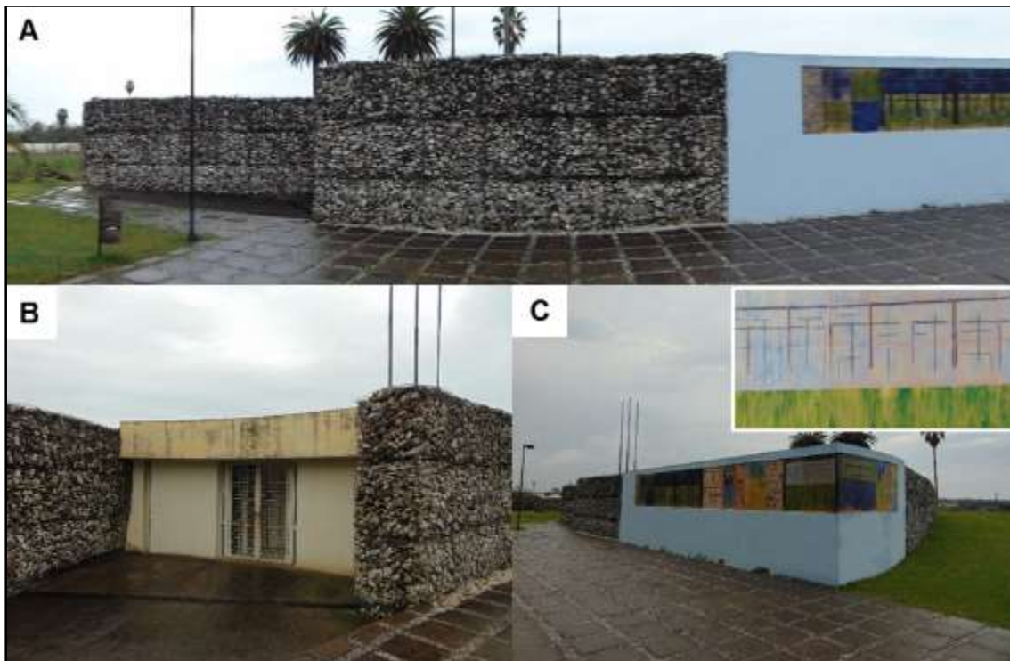
Figura 18: Intervenção contemporânea na Vila Santa Thereza, constituída de um mirante sobre os banheiros. Em A visão geral da estrutura; em B entrada para os banheiros; e em C detalhe da pintura em ladrilho, remetendo aos varais de charque (no detalhe). Bagé, RS. Fonte: autores (2019).
