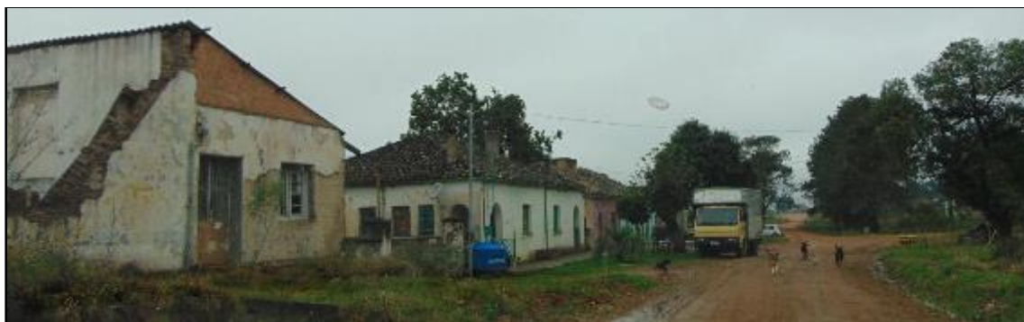
Figura 4: Construções associadas ao complexo da Charqueada São Domingos, localizadas no início da estrada de chão que leva às ruínas da Charqueada, Bagé/RS. Na seta, a rodovia BR 293. Fonte: autores (2019)
