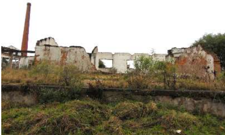
Figura 2: Ruínas da Charqueada São Domingos. Vista da área central do complexo a partir da estrada de chão. Ao fundo pode-se ver a chaminé de tijolo maciço. Fonte: autores (2019)
