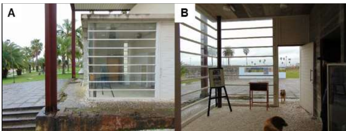
Figura 11: Intervenção contemporânea do arquiteto Flávio Kiefer. Teatro sobre a fundação do Teatro Santo Antônio, utilizando os antigos trilhos do trem na estrutura. Em A parte externa da construção, e em B o interior, fazendo alusão a um vagão de trem. Centro Histórico Vila de Santa Thereza, Bagé, RS. Fonte: autores (2019).
