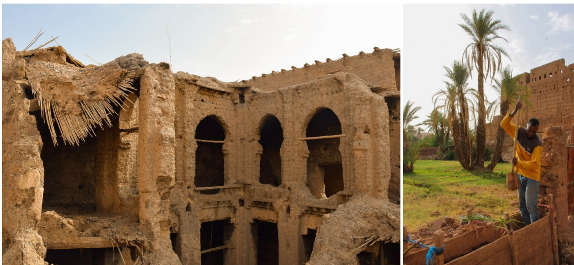
Figura 6: Arquitectura abandonada en un pueblo del valle del Drâa, en la que se aprecian los detalles constructivos. Figura 7: Proceso de apisonamiento de tierra junto a alarifes locales de Tamnougalt.
