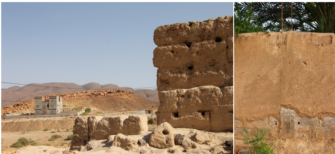
Figura 15: Ruinas de una vivienda abandonada y nueva construcción en hormigón armado. Figura 16: Detalle del muro de un recinto en hormigón con revestimiento de tierra.
