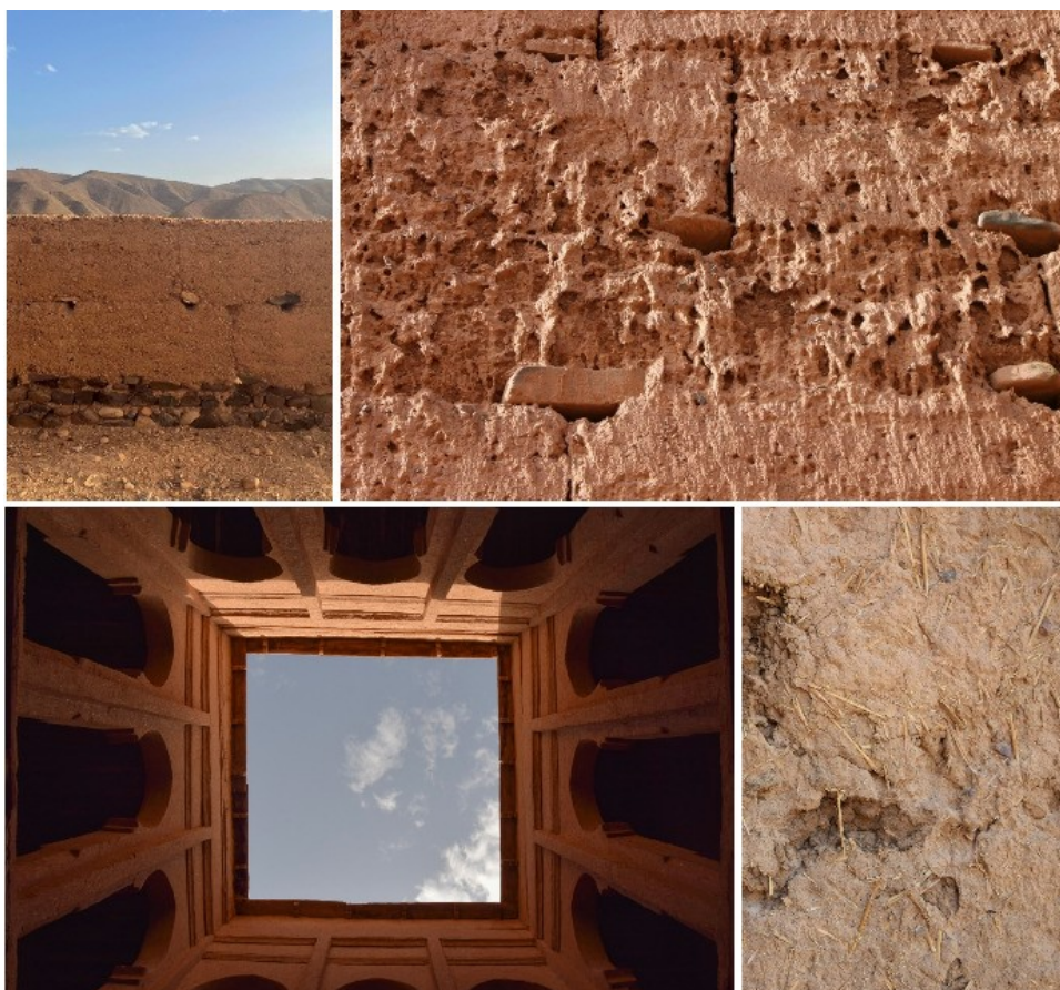
Figura 8: Tapia realizada sobre un zócalo em mampostería en la kasba de Tamnougalt. Figura 9: Detalle de una superficie erosionada por la acción del agua en un edificio del Ksar de Tamnougalt. Figura 10: El patio de una Qasba en Tamnougalt (Autor Fotografía: Roberta Petralia). Figura 11: Detalle del revestimiento con paja triturada en un edificio del Ksar de Tamnougalt.
