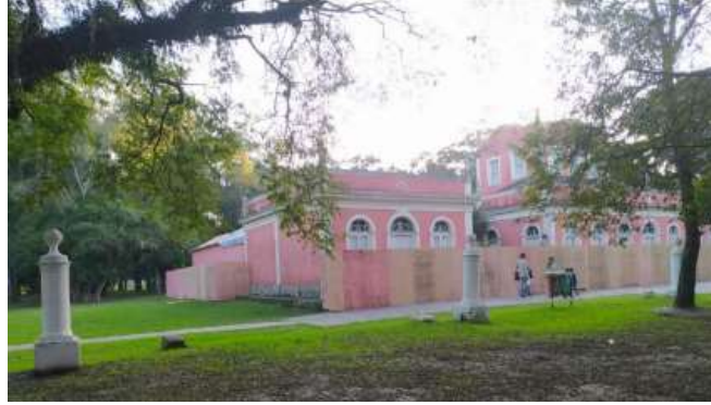
Figura 2 – Foto da residência depois da reforma. Fonte: Acervo das autoras.
