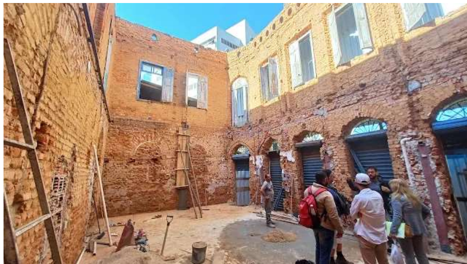
Figura 5 - Estrutura de madeira e telhado do Alcântara demolidos.
