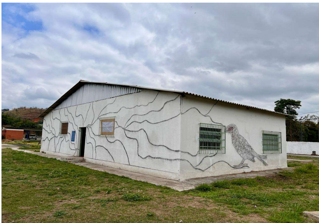
Figura 2 - Vista do MTDH, com intervenções de Ana Letícia Penedo na fachada frontal e de Rafael Crooz e Fabrício Junior na fachada lateral, na exposição Corpo-memória: uma luta vestida de sonhos . 2025. Foto: Rafael Crooz.
