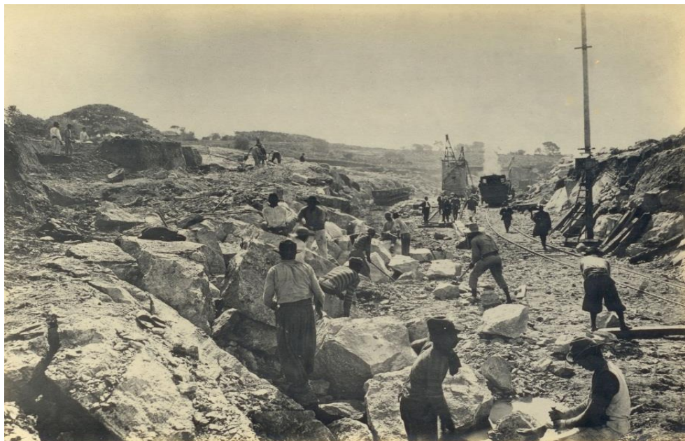
Figura 5 - Retirada das pedras para construção dos molhes. Pedreira do Capão do Leão. Início do Século XX.
