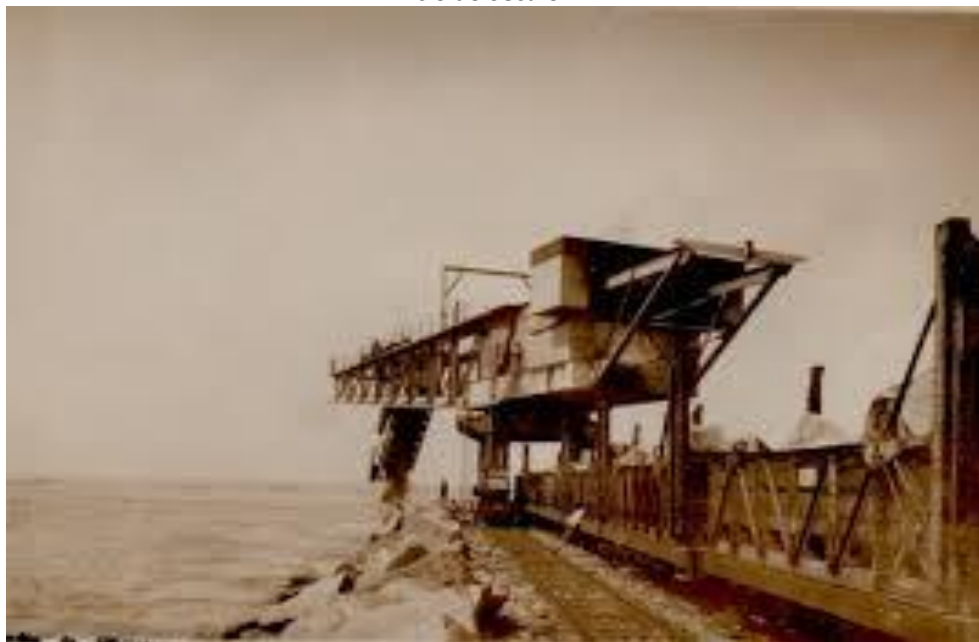
Figura 6 - Construção dos Molhes da Barra, pela Compagnie Francaise du Port do Rio Grande do Sul. Início do Século XX.
