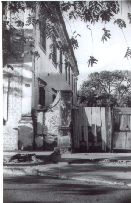
Figura 2: Casarão de João Alfredo ou Sobrado Grande da Madalena (após tombamento e antes do restauro).
