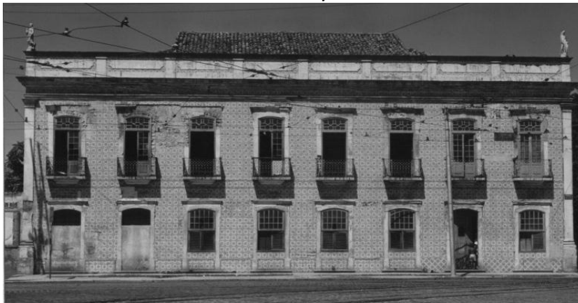
Figura 1: Casarão de João Alfredo ou Sobrado Grande da Madalena (após tombamento e antes do restauro).
