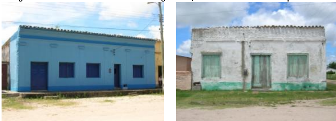
Figura 8: Residências descaracterizadas e degradadas, ambas situadas na Rua Duque de Caxias
