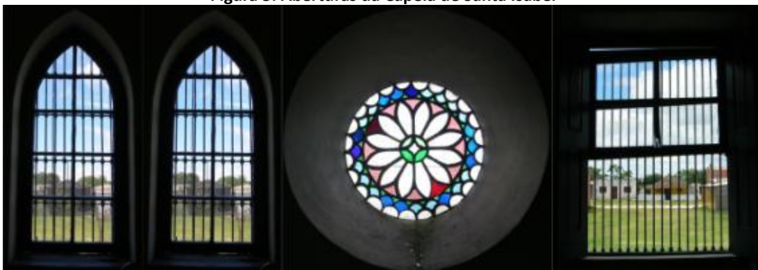
Figura 5: Aberturas da Capela de Santa Isabel
