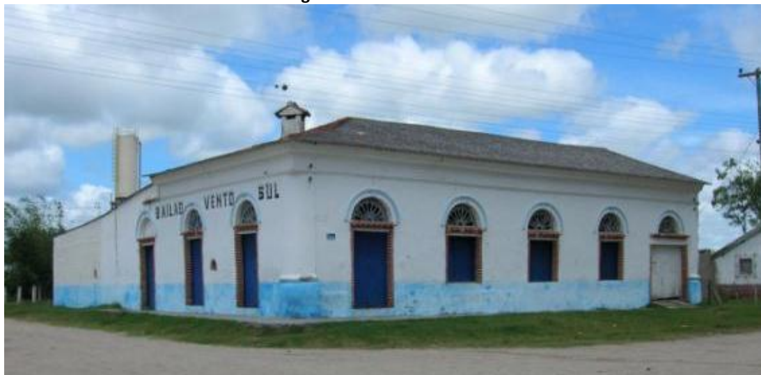
Figura 7: Bailão Vento Sul
