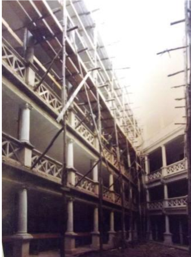
Figura 7: Fotografia da reforma no cemitério, início dos anos 1980.
