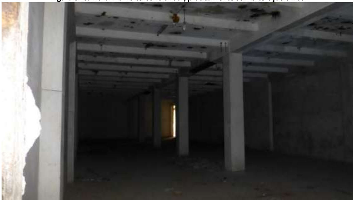
Figura 9: Câmara fria no terceiro andar, praticamente sem alteração ainda.
