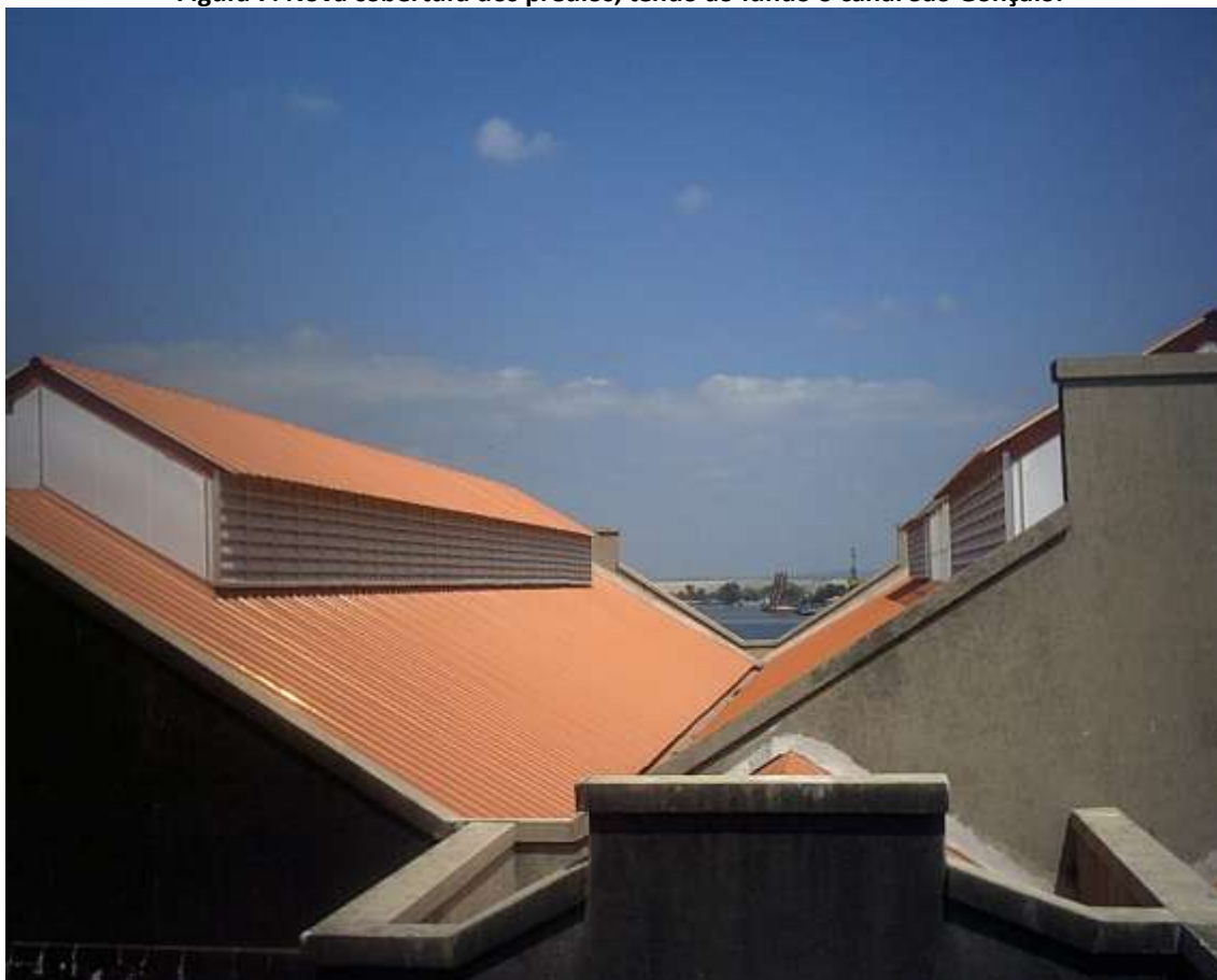
Figura 7: Nova cobertura dos prédios, tendo ao fundo o canal São Gonçalo.
