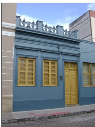
Figura 14: Residência de Eduardo Gastal, Pelotas, 2010. Fonte: Foto do autor.
