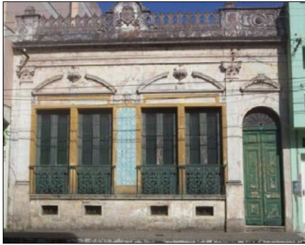
Figura 10: Residência que foi propriedade de Ismael da S. Maia, Pelotas, 1902. Fonte: Foto do autor, 2010.
