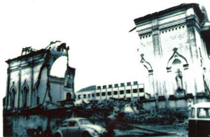
Figuras 5 e 6: Sequência de fotos da demolição. Acervo: Foto Elite
