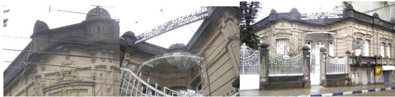
Figura 9: Fachada de cimento penteado cor terra. Palacete Domingos Gomes. Bagé, RS Fonte: Fotos Rodrigo Osório, 2009
