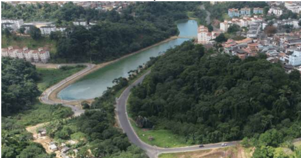
FIGURA 2 – IMAGEM AÉREA LAGOA DE ESTABILIZAÇÃO, AVENIDA ASSIS VALENTE E PEDRA DE XANGÔ
