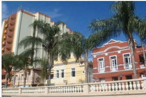
Figura 1: Parte do conjunto arquitetônico da Avenida Bueno Brandão (Balaústre), 2018. Fonte: Imagem retirada do site da Diretoria de Relações Internacionais da UFV (DRI/UFV).
