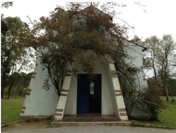
Figura 2: Fachada principal da Capela.
