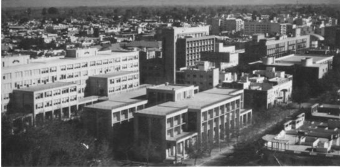
Fig. 3: Vista aérea de los edificios del Eje Cívico desde la plaza Aberastain. Foto archivo Instituto IDIS FAUD UNSJ del año 1969, correspondiente al 25° aniversario del terremoto.
