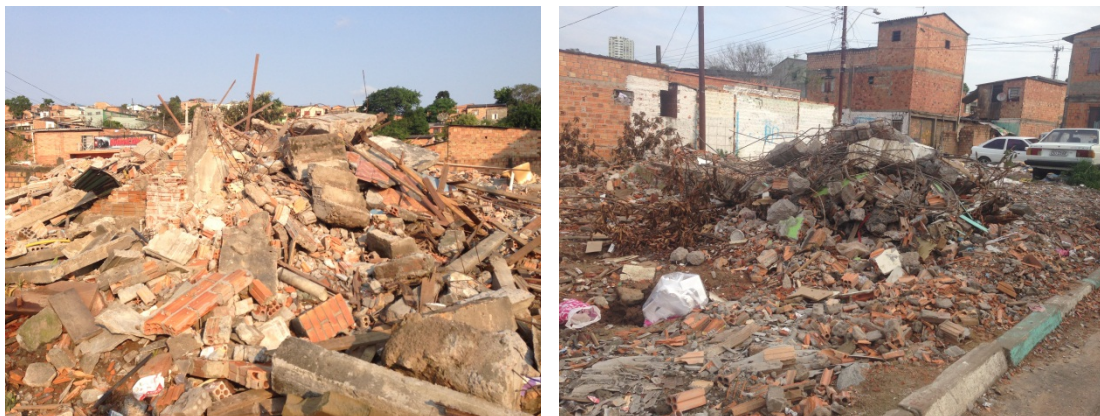
Figura 2: Escombros das casas demolidas. Fonte: SILVA, 2014.
