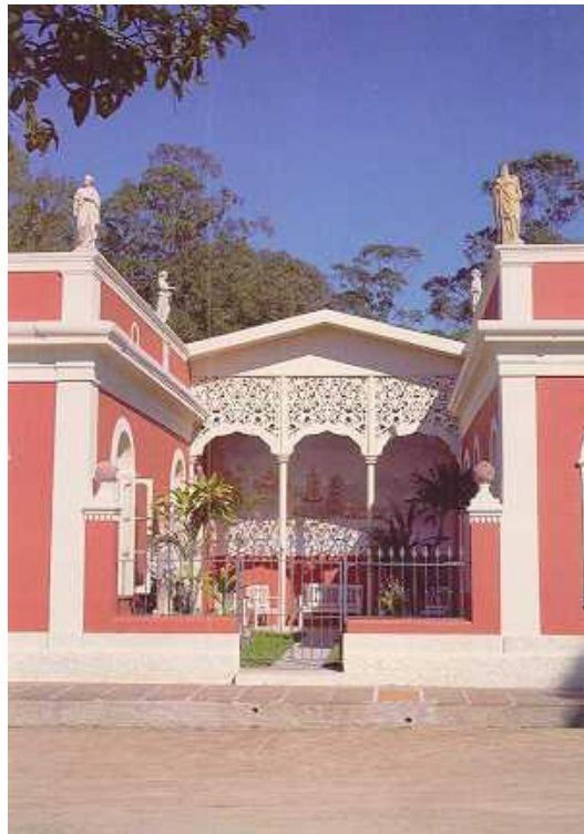
Imagem 12: Estado atual de conservação do acesso. Fonte: Projeto “A Casa Senhorial, Portugal, Brasil e Goa”, Anatomia dos Interiores. Disponível em: https://acasasenhorial.org/acs/index.php/pt/ . Acesso em: 25 de abril de 2024.
