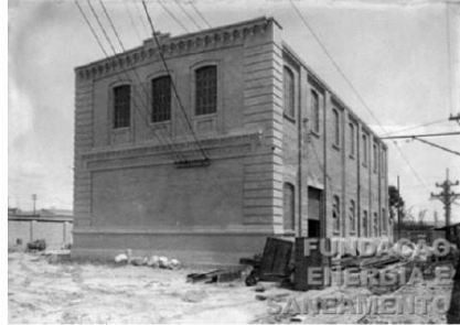
Vista externa do edifício, 1913. GAENSLY, Guilherme. Arquivo Fundação Energia e Saneamento – São Paulo / SP.
