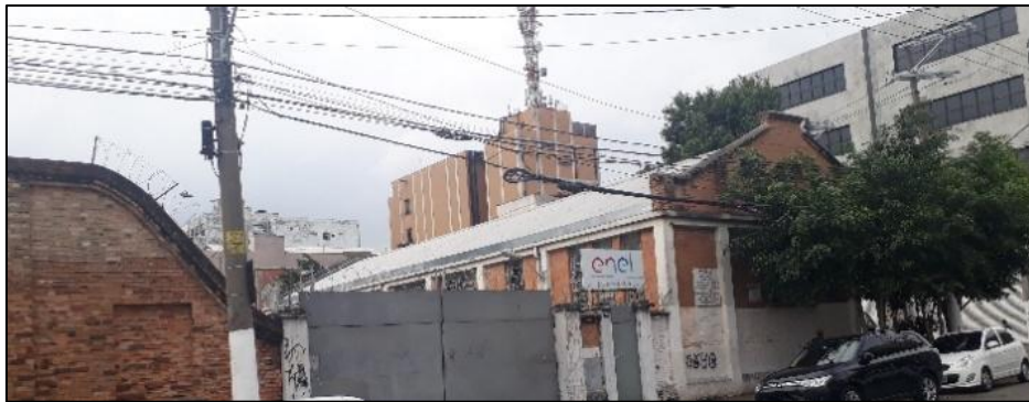
Figura 11: Edifício de subestação no Bairro do Brás. Vista da Rua Dr. João Alves de Lima. Fonte: autor, 2020
