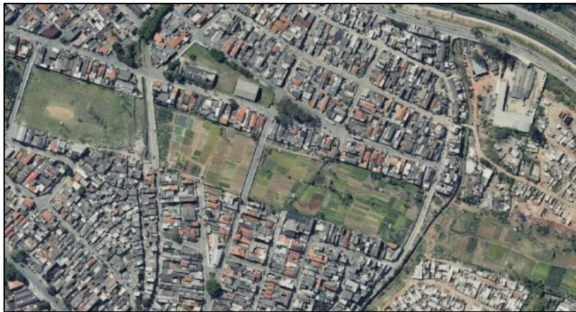
Figura 2: Recorte da Ortofoto de 2017, mostrando a mesma localização do mapa SARA Brasil de 1930. Rede de transmissão próxima à Rua Silva Ortiz, Jardim Nove de Julho, São Mateus, SP. Fonte: Portal GeoSampa (PMSP).
