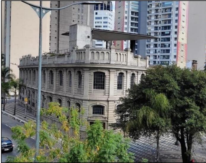
Figura 12: Edifício da antiga subestação Central – Riachuelo, no centro de São Paulo. Fonte: autor, 2021.
