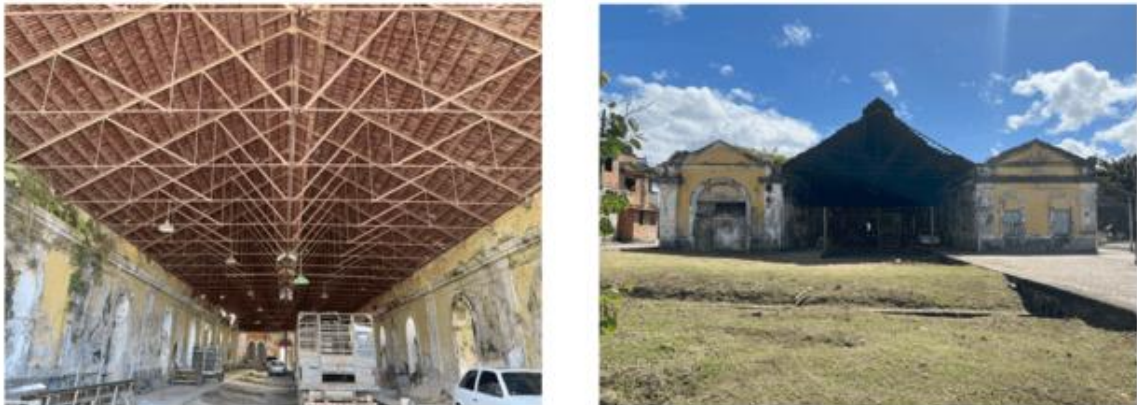
Figura 3: Parte interna da estação ferroviária e vista externa da gare da estação.
