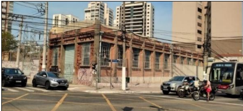
Figura 10: Edifício da subestação do bairro Vila Mariana. Vista da Rua Domingos de Moraes. Fonte: autor, 2021.
