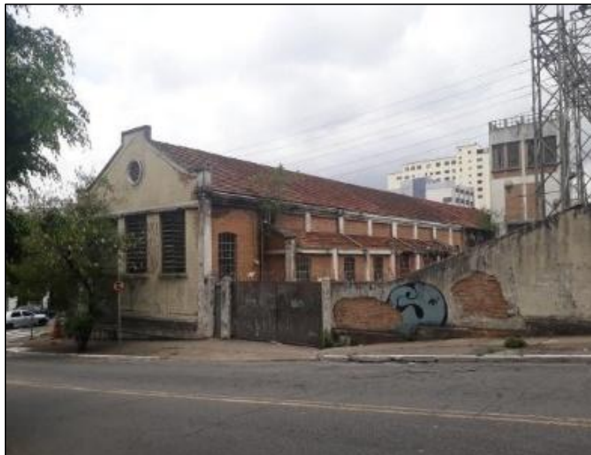
Figura 8: Edifício da subestação do bairro do Ipiranga. Vista da Rua Xavier Curado. Fonte: autor, 2019.
