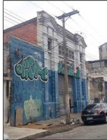
Figura 13: Edifício da antiga subestação Cruz Branca, no Brás. Fonte: autor, 2019.
