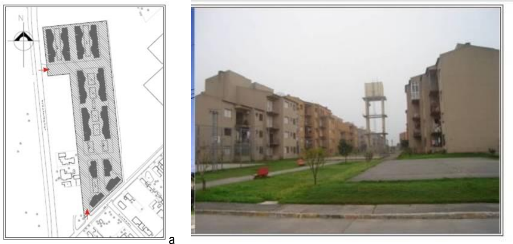
Figura 4: a e b) implantação visual interna do Residencial Rua Brasil. Fonte: cadastro dos conjuntos residenciais construídos em Pelotas.
