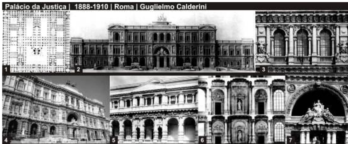
Figura 2: Palácio da Justiça. Roma. Arquiteto G. Calderni. Fonte: arquivo da biblioteca digital da Universidade de Bolonha. Disponível em: < http://amshistorica.cib.unibo.it/diglib.php?inv=136 >. Acesso em: 21 mar 2011. Edição: da autora, 2011.
