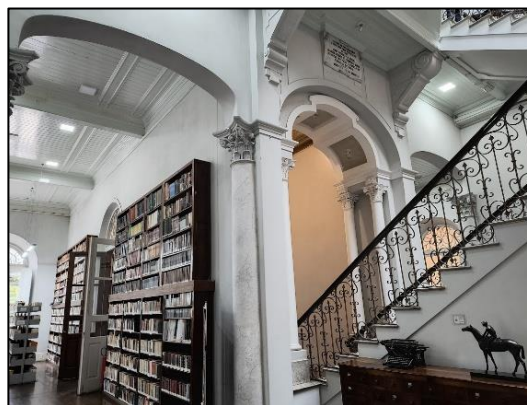
Figura 08: Vista dos arcos atuais, 2024.
