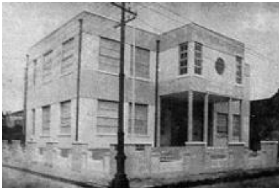
Figura 2 – Fachada do prédio do Grupo Escolar Benjamin Constant, provavelmente na década de 1930
