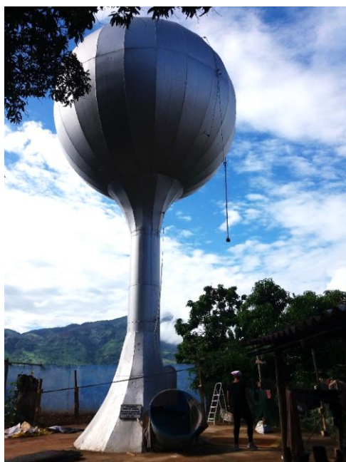
Figura 2 – Caixa d’água: “Bioquê do Prefeito”
