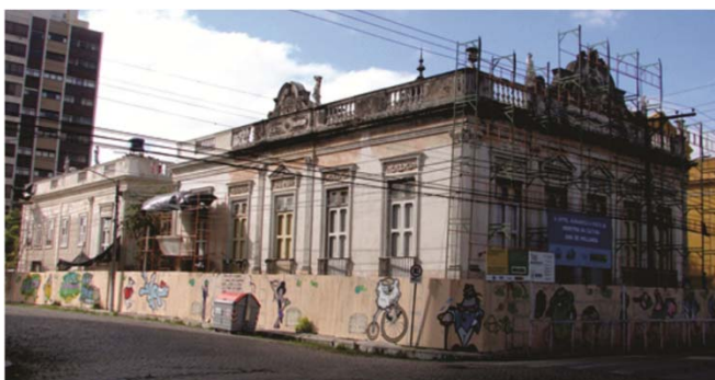
Figura 1. Fachada del predio del Casarão do Barão de Cacequi, más conocido como Casarão 8. Situación actual. (Foto: Acervo de los autores, marzo de 2012).
