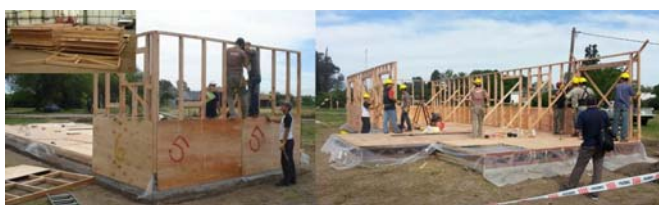
Figura 6. Colocación de paneles de muro-nivelación. Figure 6. Positioning the grading panels.
