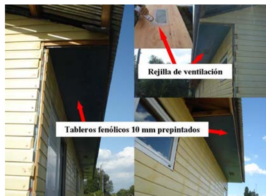
Figura 13. Aleros con ventilaciones de techo.
