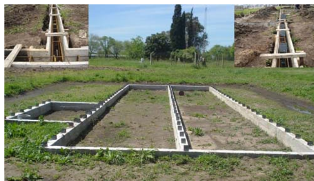
Figura 3. Fundaciones de hormigón armado. Figure 3. Concrete foundation.
