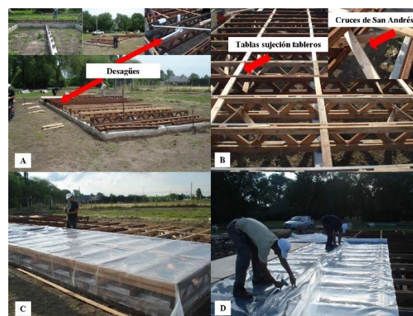
Figura 4. A. Colocación vigas reticuladas de madera-desagües; B. Cruces de San Andrés y “encuentros” Tableros fenólicos; C. D. Colocación-sellado-fijación polietileno de 200\ \mu\text{m} .
