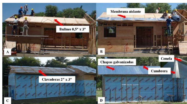
Figura 9. Armado de techo.
