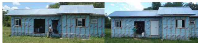
Figura 11. Colocación de aberturas.
