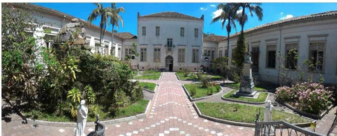
Figura 2 - Pátio interno do Asilo de Mendigos de Pelotas
