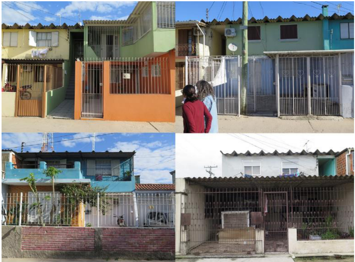
Figura 8 - Unidades residenciais com presença de gradis metálicos.
