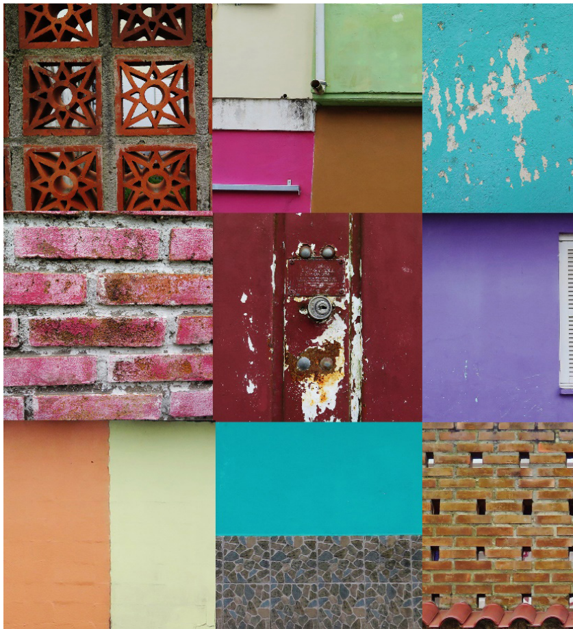
Figura 4 – Fotomontagem com detalhes dos revestimentos das fachadas.
