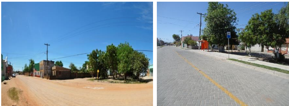
Figuras 2 - Rua Paulo Guilayn antes e após a obra de pavimentação.
