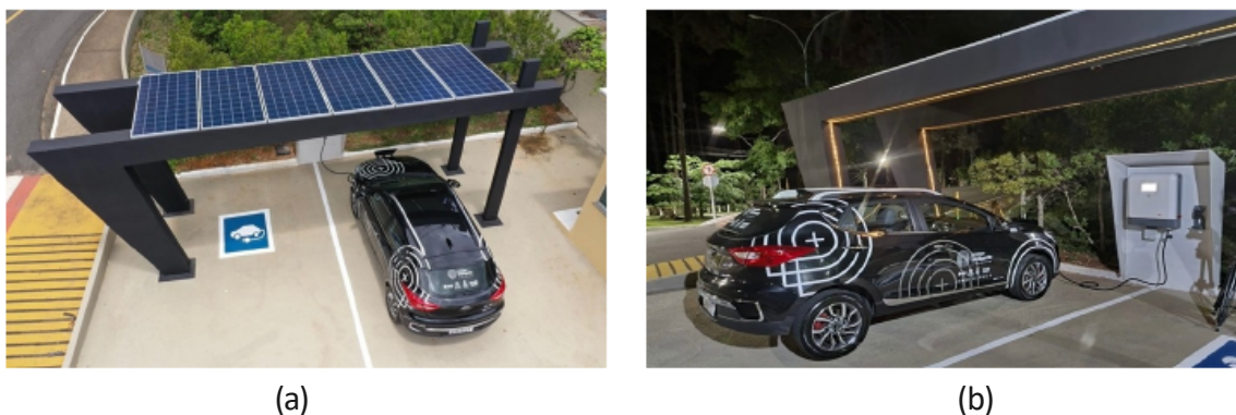
Figura 4 – Carpot PUC. a) Vista superior donde se podem observar os painéis solares, b) Vista frontal do eletroposto em uso.
