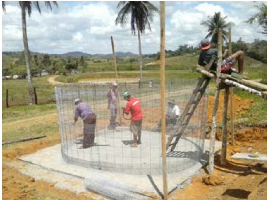
Figura 9 Tela de pinteiro sendo amarrada à malha pop com arame recozido Foto: AGUIAR, P. C. B. de. (2014).
