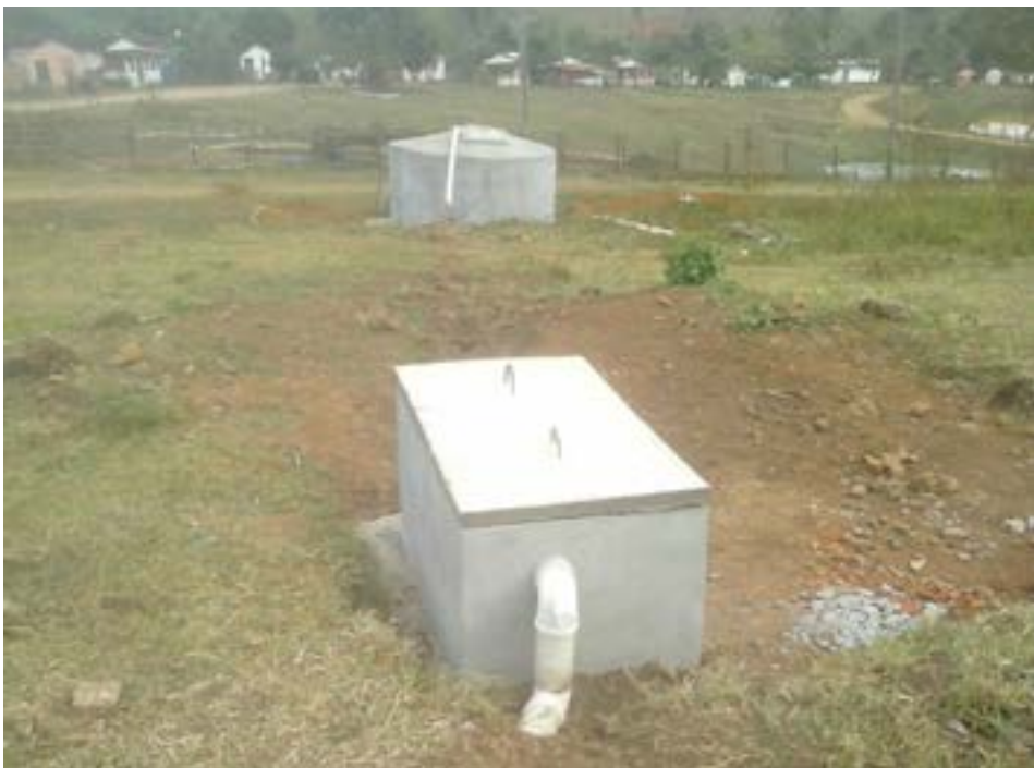
Figura 13 Caixa de filtragem e tanque de armazenamento construídos Foto: AGUIAR, P. C. B. de. (2014).
