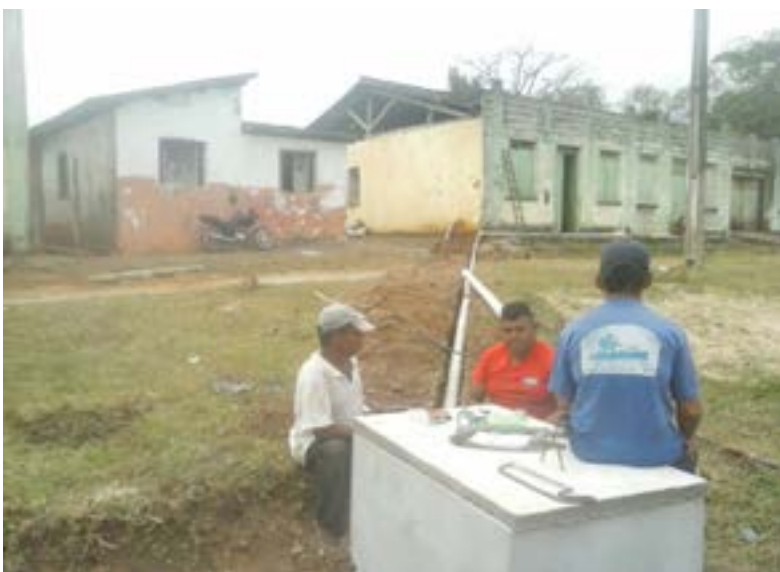
Figura 14 Instalando a encanação do prédio da associação à caixa de filtragem Foto: AGUIAR, P. C. B. de. (2014).
