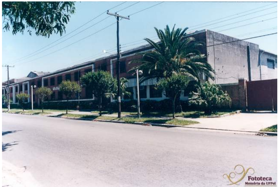
Figura 7 Fachada da Laneira S.A. Fonte: Projeto de Ensino - Reciclagem e requalificação de espaços industrial para implementação de Museus Inclusivos/UFPel, 2014.
