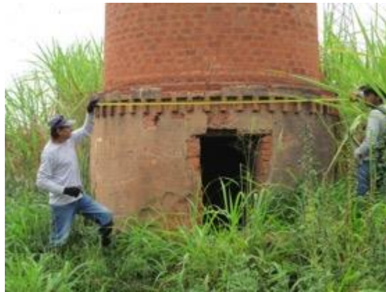
Figura 06: Medição da base da chaminé. UTM (SAD 69) 23K 0258.367E / 7.7512.543N. Foto extraída do Relatório de Prospecção Trecho 2 (Fonte: ECOSSIS, 2015, p. 121).
