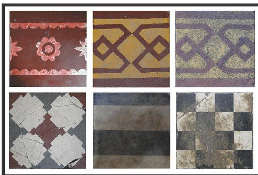
Figura 8. Patologias encontradas nos ladrilhos hidráulicos de Cachoeira - BA: 1) Mancha feita com por uso de cera vermelha; 2a) Superfície lisa; 2b); Superfície porosa; 3) Trincas e fissuras; 4) Manchas e 5) Opacidade. Fotos: Caroline Pereira Teixeira e Aline Marçal Santos, 2015.
