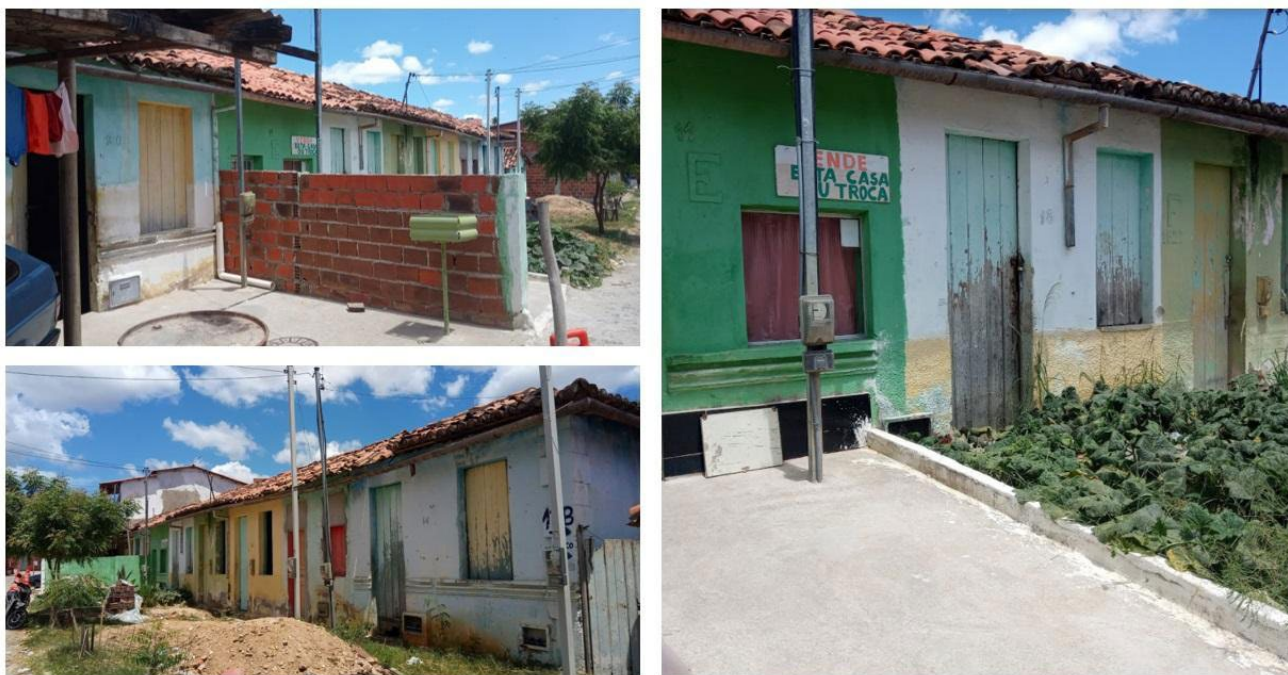
Figura 4. Barracamento (Casas de turma) na Rua da Linha. Foto: Gustavo Santos, 2021.
