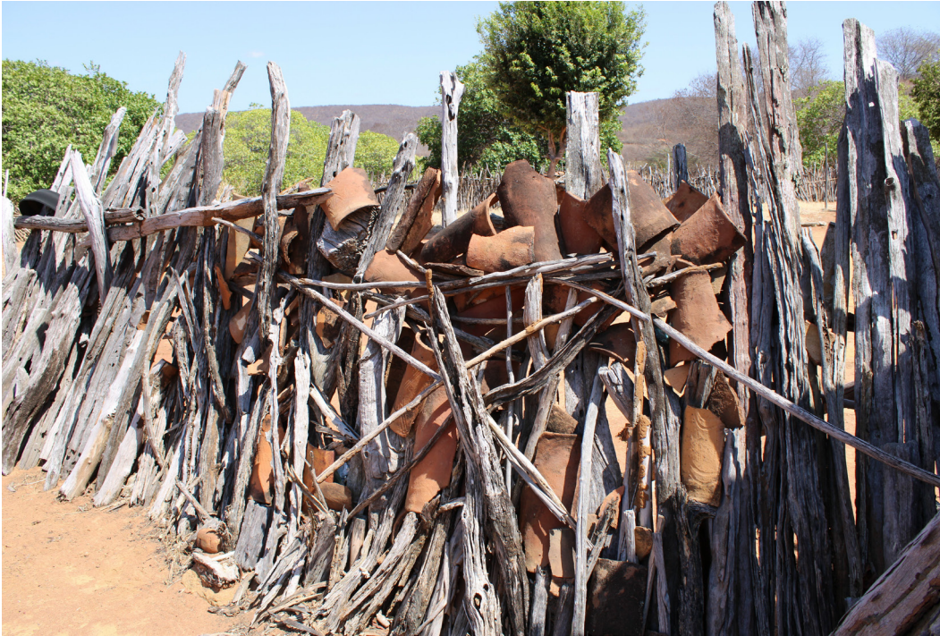
Figura 8: Telhas de fabricação local, remanescentes do telhado da casa, reutilizadas na composição de trechos das cercas.
