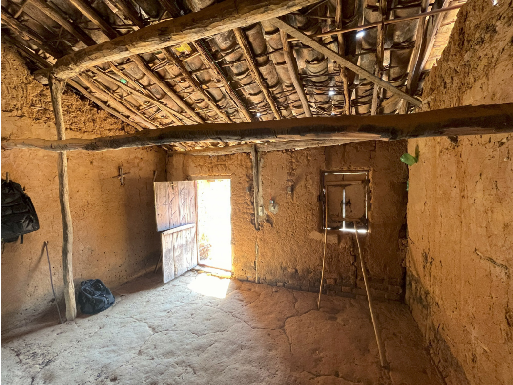
Figura 6: Visão geral do “cômodo de receber visitas”. Percebe-se características que se repetem em outras partes da edificação, como os tijolos e a taipa, o chão de terra batido e o telhado com cumeeira de angico, incorporando telhas produzidas localmente e materiais construtivos contemporâneo, como garrafas de plástico e latas de alumínio, que por sua vez parecem ter servido ao propósito de emendar fissuras.
