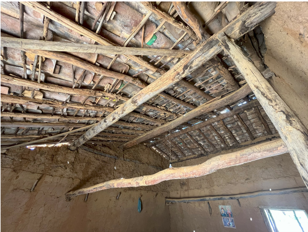
Figura 7: Detalhe de telhado e suas cumeeiras.
