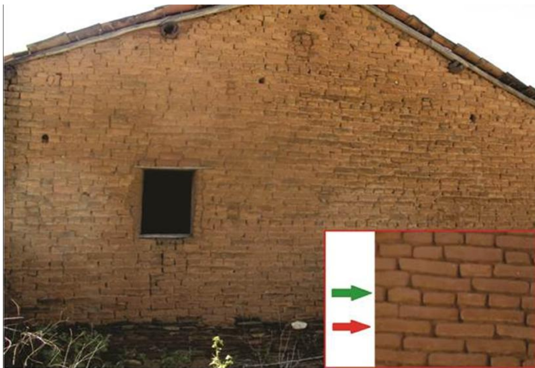
Figura 07: Parede externa de adobe a tição e a vela (Foto: RIBEIRO, Marcelo Alves, 2013)
