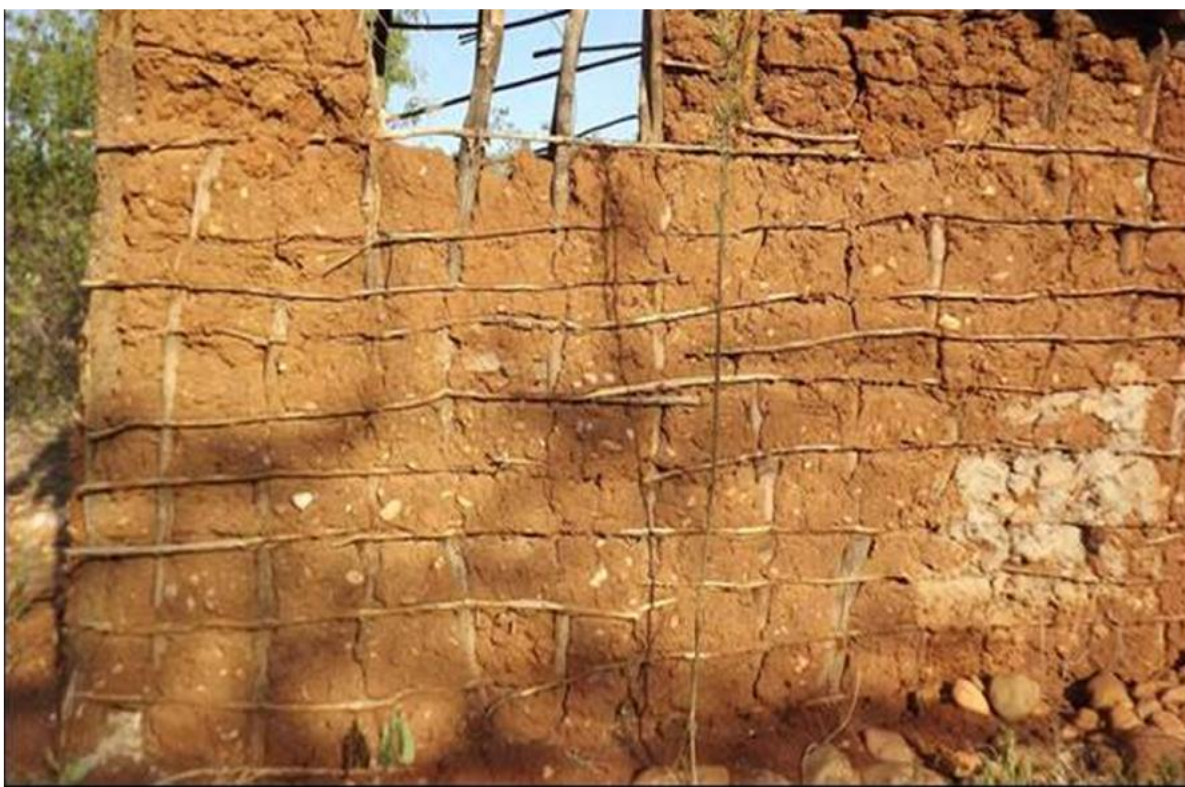
Figura 01: Parede de uma casa de taipa (Foto: Rômulo Macedo, 2013)
