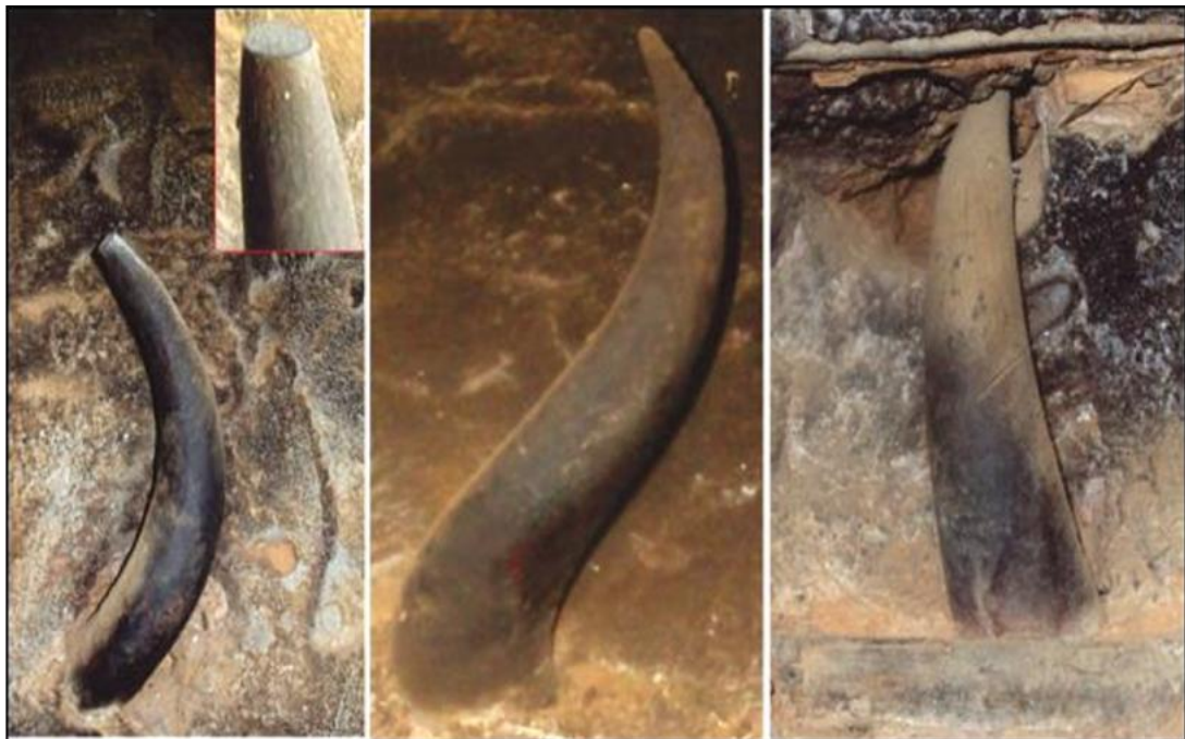
Figura 10: Tornos de chifre de gado nas paredes (Foto: RIBEIRO, Marcelo Alves e MACÊDO, Rômulo)
