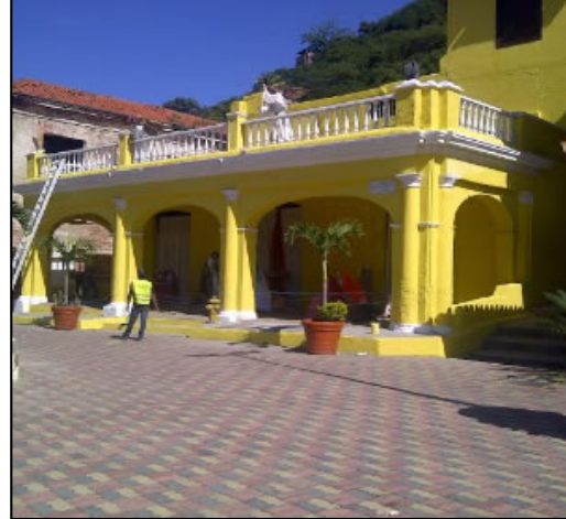
Imagen 10: Imagen tomada de Abrebrecha.com http://www.abrebrecha.com/330872_Infravargas-recupera-emblem%C3%A1tica-casa-amarilla-de-la-Guaira.html .
