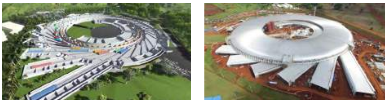
Figura 6: (esquerda) Concepção artística da nova fonte de luz síncrotron Sirius e (direita) estado das obras em março de 2018. Fonte: LNLS/ Divulgação.
