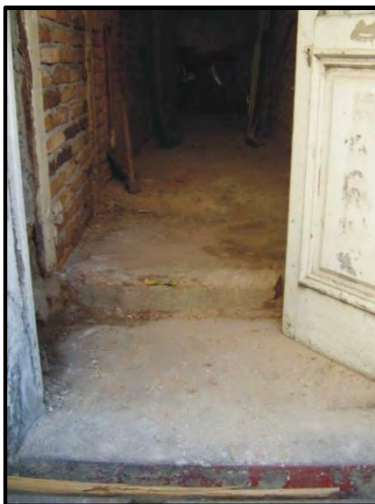
Figura 14: Piso do banheiro.
