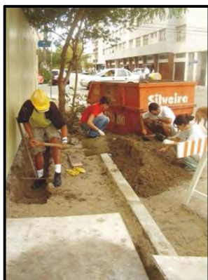
Figuras 29 e 30: Abertura de vala na calçada X.
