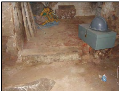
Figura 05: banheiro antes da intervenção
