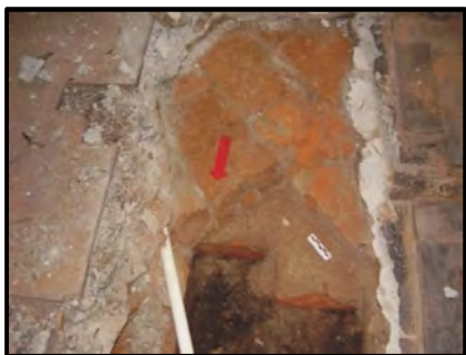
Figura 12: 1º e 2º camadas do piso de tijolos
