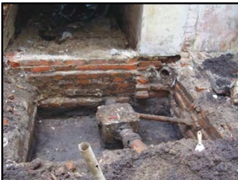
Figura 26: Área do banheiro após remoção do aterro. Fonte: Acervo do IMP
