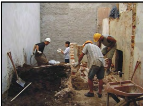
Figura 25: Demolição do banheiro Fonte: Acervo do IMP
