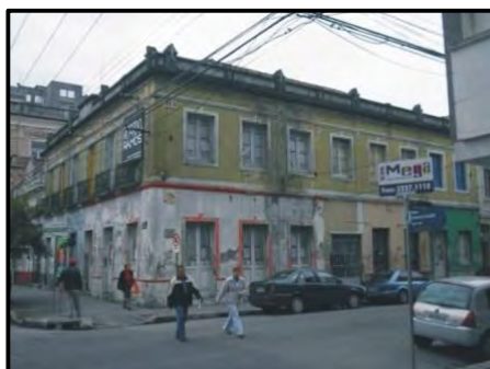
Figura 01: Fachada da Casa da Banha antes da reforma (2007)
