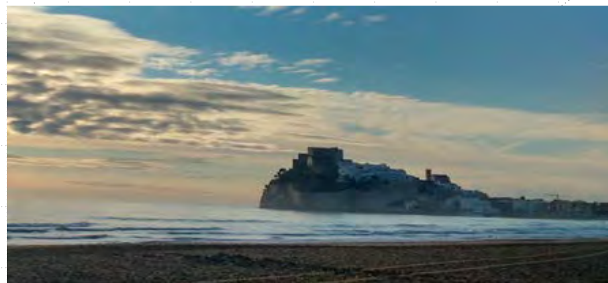
Figura 1. Vista panorámica de la ciudad de Peñíscola (España). Archivo personal.
