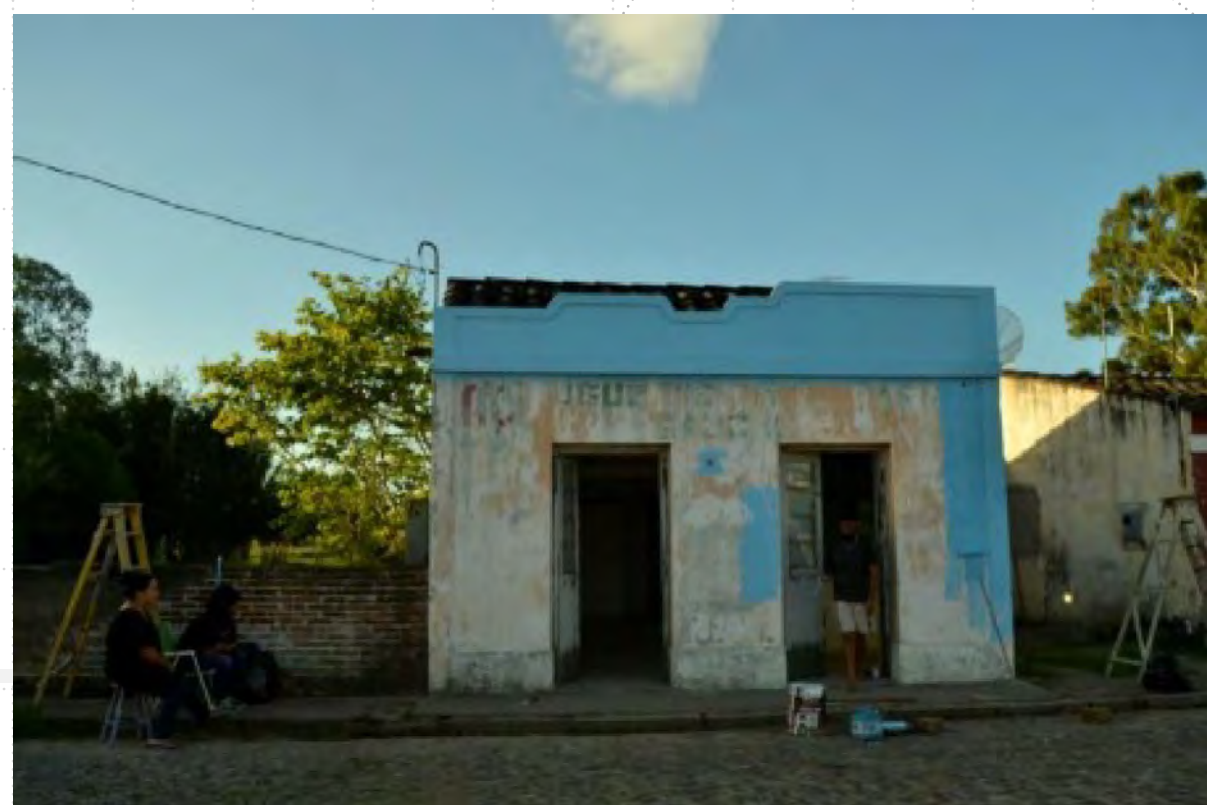
Figura 2. Nauita Meireles e Anieli Martins. Centro Compacto de Devaneio. Localizado na Rua das Flores, 27 em Pedro Osório-RS. Processo de Pintura da casa. Fonte: Arquivo da autora.
