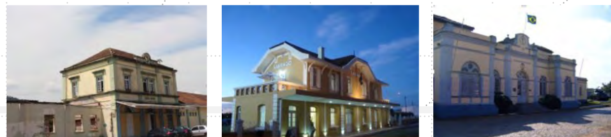
Figura 1. À esquerda, registro fotográfico do atual estado de conservação do antigo prédio da estação de Santa Maria. No centro, está o registro do prédio Estação do Conhecimento Santiago, RS. Fonte: Tatiane Palma. Site Prefeitura Municipal de Santiago, disponível em: https://goo.gl/3BPXLF . Acesso em: 29 mar. 2016. À direita, registro do prédio da antiga Estação Férrea de São Gabriel, atual Museu Gaúcho da Força Expedicionária Brasileira. Fonte: Site Prefeitura de São Gabriel, disponível em: https://t.ly/Hszh . Acesso em: 29 mar. 2016.
