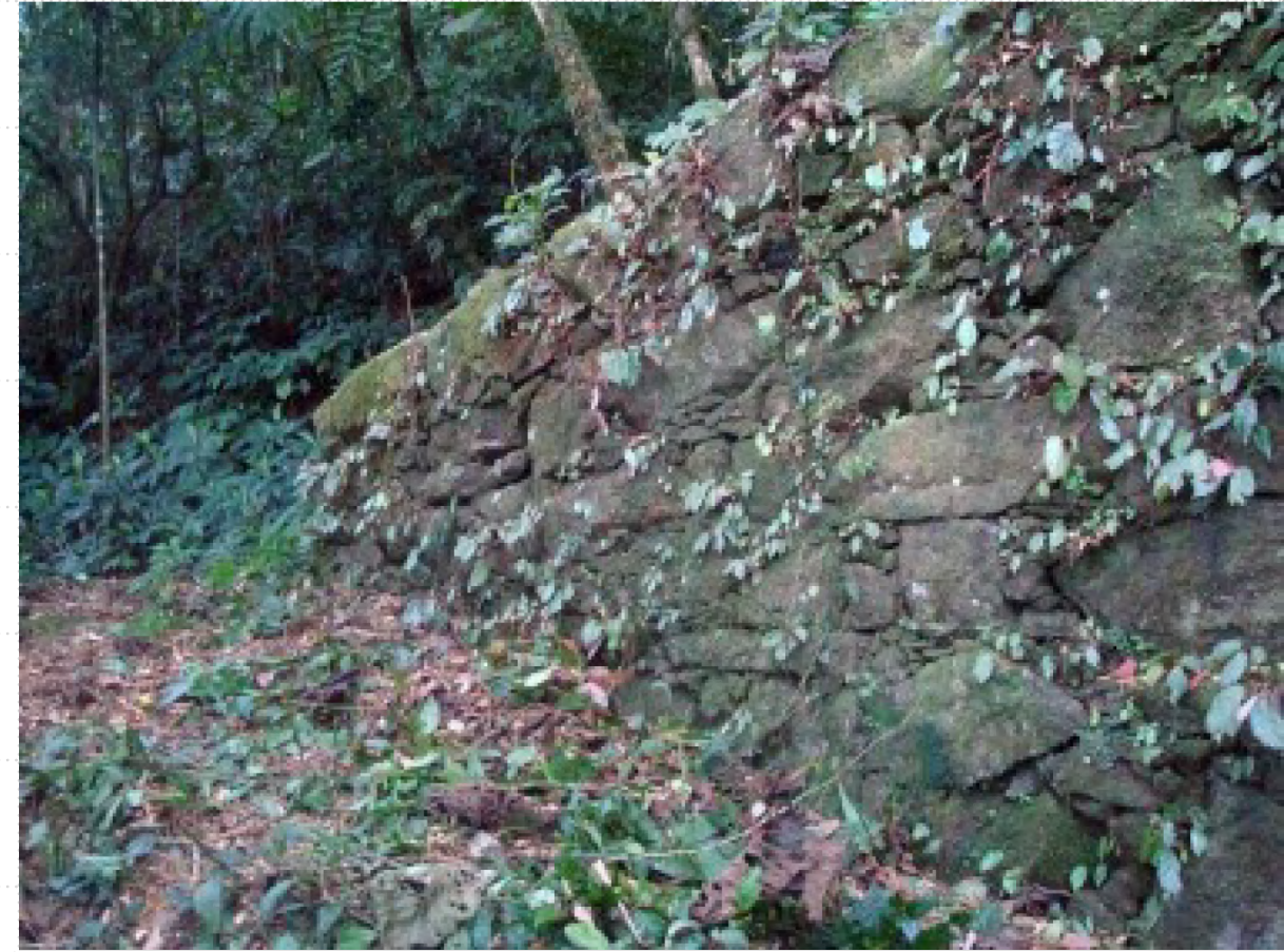
Figura 6. Trecho da Trilha dos Sete Degraus em ruínas. Fonte: Os autores
