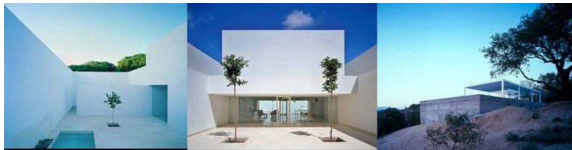
Figura 6 - Casa Gaspar. Casa Guerrero. Casa Blas Fuente: Exposición Pensar con las Manos. LOS DIBUJOS DEL ARQUITECTO. Alberto Campo Baeza.
